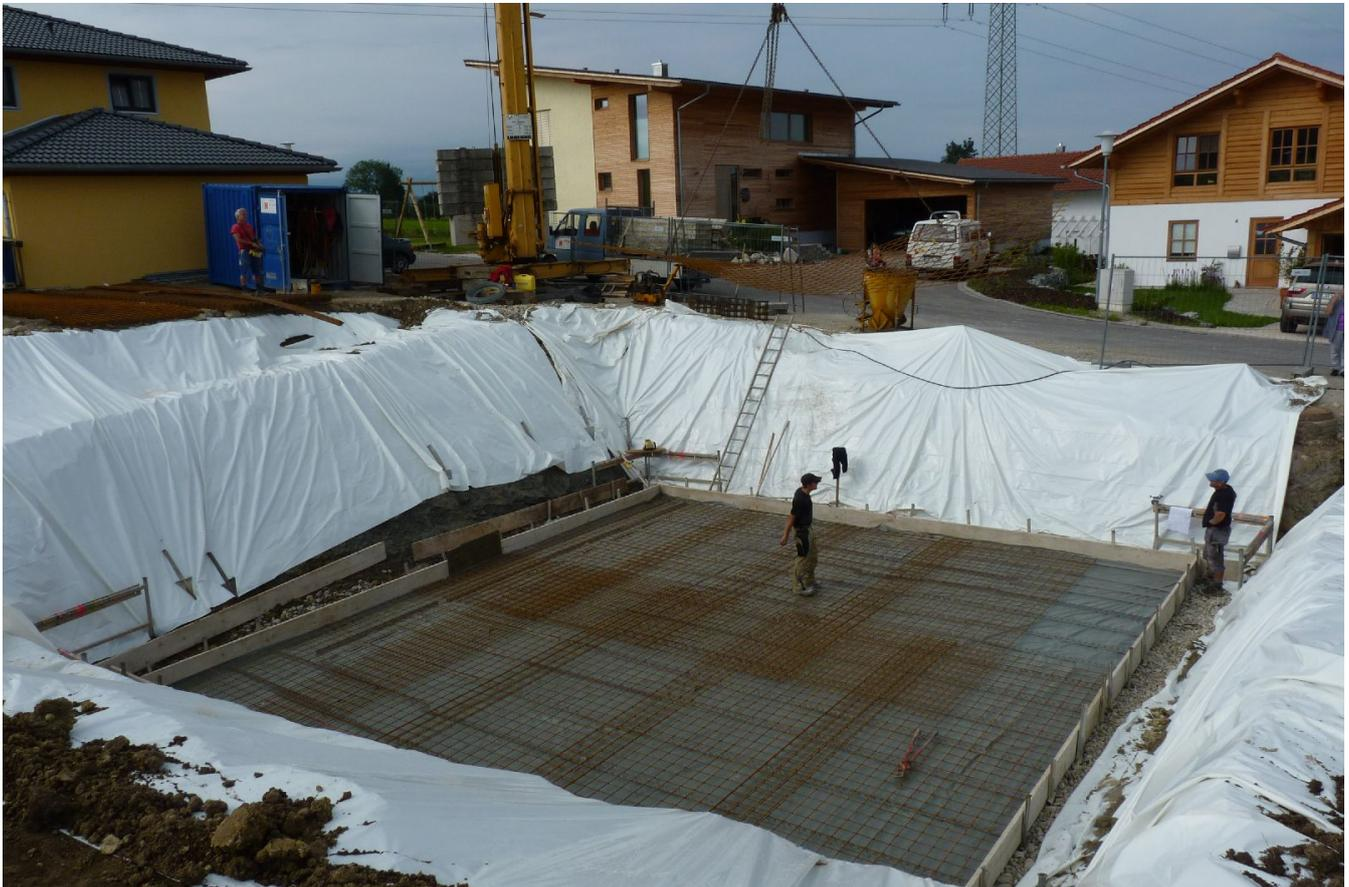
Damit war alles soweit vorbereitet, um eine 25 cm dicke Betonschicht einzufüllen.
